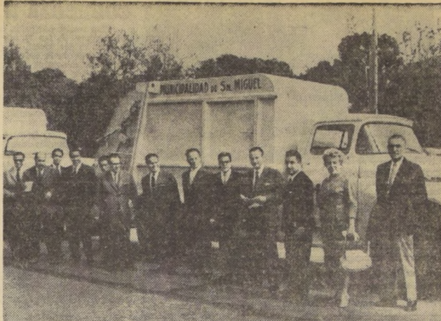
ENTREGA DE MAQUINAS EXTRACTORAS DE BASURAS EN SAN MIGUEL.— Ayer se efectuó la entrega de once unidades extractoras de basuras para el servicio de esta comuna, con la cual se soluciona el difícil problema sanitario que afecta a San Miguel. En el grabado aparece el alcalde de San Miguel, regidores e invitados al acto de recepción, al pie de una de las modernas máquinas.
