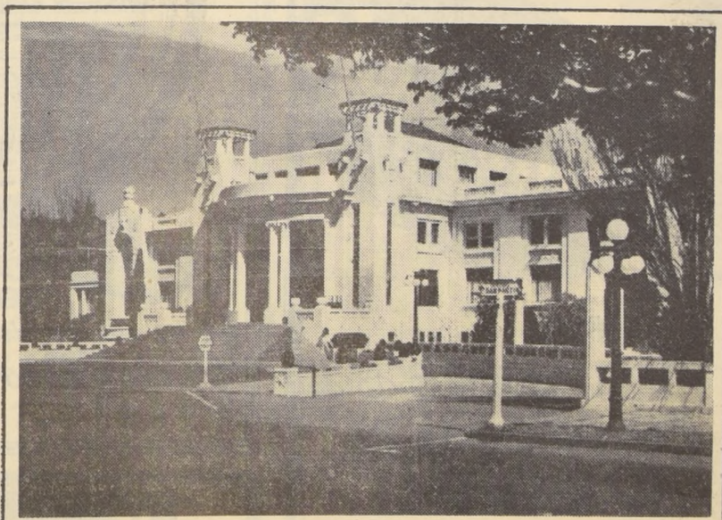
FACHADA DEL CASINO MUNICIPAL DE VIÑA DEL MAR
