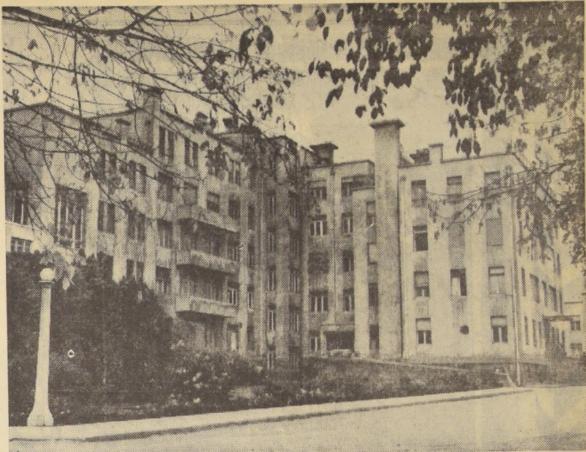
Edificio que se yergue en Antonio Varas esquina de Simón Bolívar, y en el que funciona el Hospital de Carabineros que cuenta con 22 servicios y atiende pacientes de todo el país.
