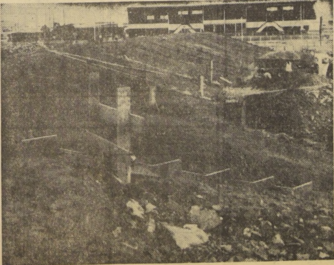
VISTA PARCIAL del talud sur del Estadio Regional de Antofagasta, terminada ya su obra gruesa. El del lado norte está en idénticas condiciones.
