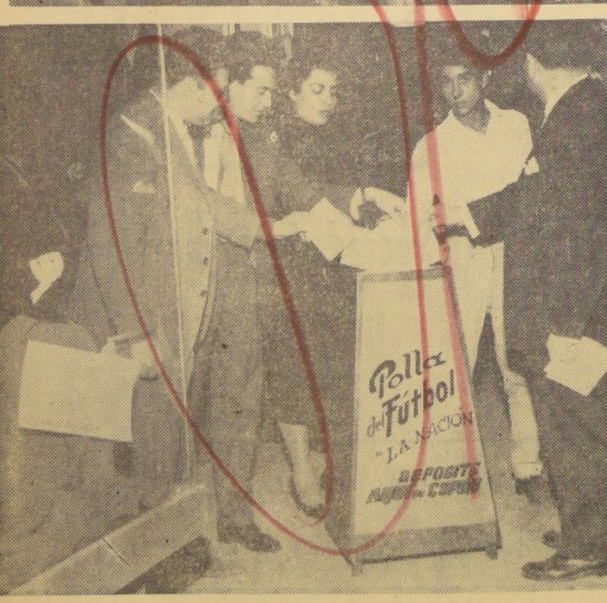
La Sastrería "Dandy", de Jaime Cogan, ubicada en San Diego 673 al 677, está recibiendo, junto con nuestro diario, los cupones de la POLLA DEL FUTBOL DE LA NACION y para este fin tiene un buzón en su establecimiento, donde los lectores de ese sector están participando en este interesante y original concurso. En los grabados, en primer término, el frontis de la Sastrería de Jaime Cogan, y a continuación, un grupo de lectores deposita sus cupones para el sorteo de esta semana.
