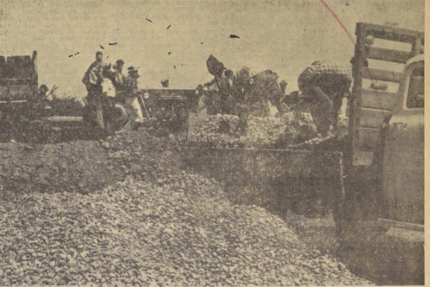
CAMINOS PARA CHILE.— Una labor extraordinaria se ha desarrollado en los últimos 12 meses, en caminos, ya que, además de los programas ordinarios de trabajo que se han estado cumpliendo, ha habido que atender la reconstrucción, en algunos casos, y en otros, la reparación de caminos y puentes destruidos o afectados por los terremotos de mayo. El cumplimiento de estas tareas ha hecho que la Carretera Panamericana una vez, por medio de una hinchada continua de cemento, desde La Serena hasta Los Angeles, y que muy pronto llegue hasta Temuco. Además, de Temuco a Puerto Montt ya se ha pavimentado diversos sectores. En el grabado aparecen trabajadores que, con adecuada maquinaria, preparan un sector del camino de Temuco al sur.
