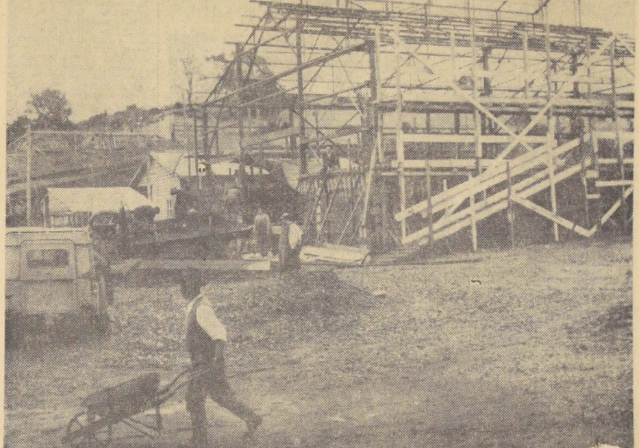
Uno de los más graves problemas de Chiloé es el de la energía eléctrica; pero ya se encuentran en pleno trabajo las obras proyectadas por la ENDESA para esa provincia, las que permitirán disponer de la suficiente energía para su industria y el alumbrado de sus ciudades. La Planta de Píruquina, ubicada a cincuenta kilómetros de Ancud, estará lista en septiembre próximo. En el grabado, la subestación Pudeto, Ancud, de la Planta Píruquina, en plena construcción, la que invierte en ejecución el Gobierno 2.488 millones. (Foto de Oscar Rosales, enviado especial).
