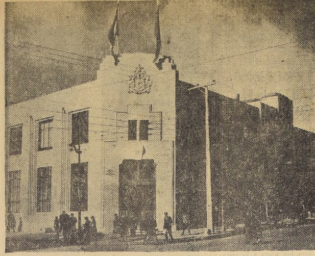
TALCA.— INAUGURACION DE CENTRAL TELEFONICA AUTOMATICA.— Ayer fue inaugurada la nueva central telefónica automática de esta ciudad, que quedó instalada en un moderno edificio, en la esquina de las calles 1 Sur y 4 Oriente. La nueva planta se inicia con una capacidad de 2.600 líneas, y representa un aumento de 150% sobre las líneas anteriormente existentes, y una inversión de $1.100.000. La ceremonia inaugural fue presidida por el Subsecretario del Interior, don Jaime Silva, quien puso en marcha los nuevos equipos, quedando así conectados de inmediato a la red automática todos los suscriptores de la Compañía. En el grabado, aparece el nuevo edificio de la Compañía de Telefonos de Chile, en el que ha quedado instalada la planta automática.
