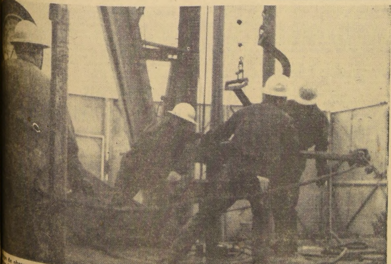
Los obreros especializados de la ENAP accionan los mecanismos para perforar uno de los pozos descubiertos en el Estrecho de Magallanes. De 37 pozos perforados en este lugar, treinta y tres resultaron productores de petróleo, uno de gas y sólo tres secos. O sea, que el rendimiento arroja un 90 por ciento de resultados favorables.
