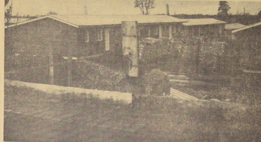
Obreros contratados por el CORVI trabajan activamente en levantar las últimas casas de la Población "Hurtado de Mendoza", en Osorno. Miles de poblaciones como esta han sido construidas y construye el CORVI en todo el país, especialmente en la zona damnificada, de acuerdo con la política nacional del Supremo Gobierno. Igualmente, la iniciativa privada está recibiendo un gran impulso en este rubro de la actividad constructora.
