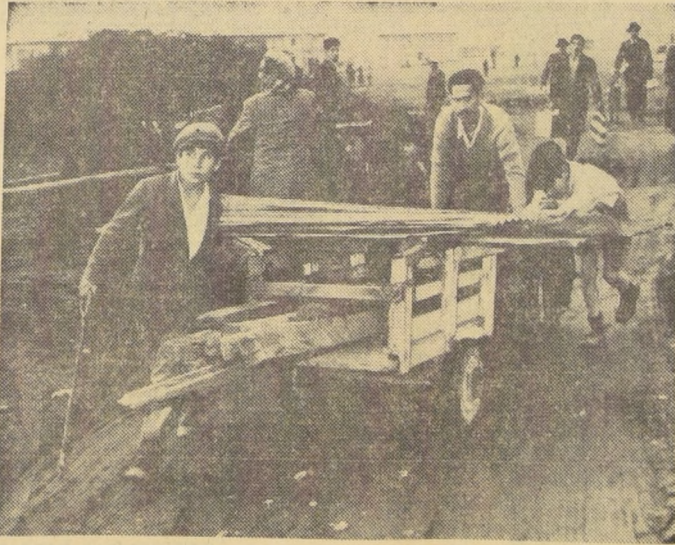
AYUDADO POR SUS HIJOS y otros niños, llegados a Santa Adriana el tejedor José Mehlado. Los pobladores que invadieron el sitio de la CORVI utilizaron todo tipo de materiales para llegar con sus enseres y materiales de construcción a levantar las viviendas.
