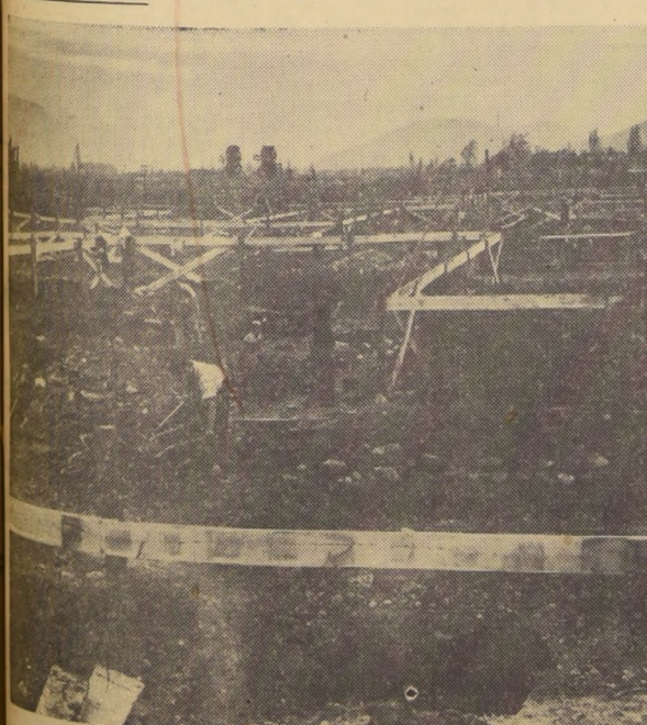
El Plan Habitacional que ha puesto en marcha la Corporación de la Vivienda, sigue la línea que el Supremo Gobierno ha impuesto para disminuir el déficit habitacional del país. En Santiago, se están efectuando los heridos para los cimientos de una nueva Unidad Vecinal. Será una ampliación de la Población J. A. Ríos, Sector 2-B. Numerosos obreros están trabajando en estas tareas que deben quedar terminadas dentro de poco tiempo más para iniciar las obras de edificación. EN EL GRABADO se puede observar a grupos de estos obreros que trabajan rompiendo la tierra que mañana será un sector urbanístico moderno del Gran Santiago.
