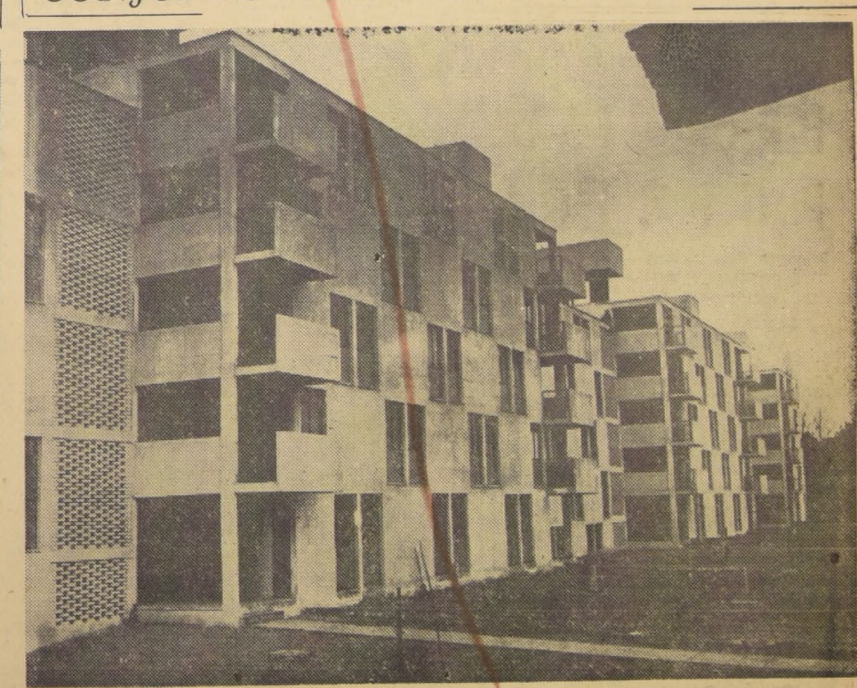
En la construcción de la Complementación de la Población San Gregorio en el sector de Santa Rosa, efectuada por la CORVI, se ha contemplado en todos sus aspectos la armonía arquitectónica del conjunto. Son bloques de 5 pisos con 4 departamentos por piso en un total de 160 viviendas. Cada uno de los pisos superiores tiene una terraza cubierta y los del primer piso un patio individual. La entrega de estos departamentos deberá hacerla la CORVI en breve tiempo más a las Cajas de Previsión que los han adquirido para entregarlos a sus imponentes que han solicitado una vivienda de acuerdo a sus reglamentos internos. En el grabado puede apreciarse una vista posterior de los edificios que forman la Unidad Vecinal San Gregorio, listos para ser ocupados por sus adquirentes.
