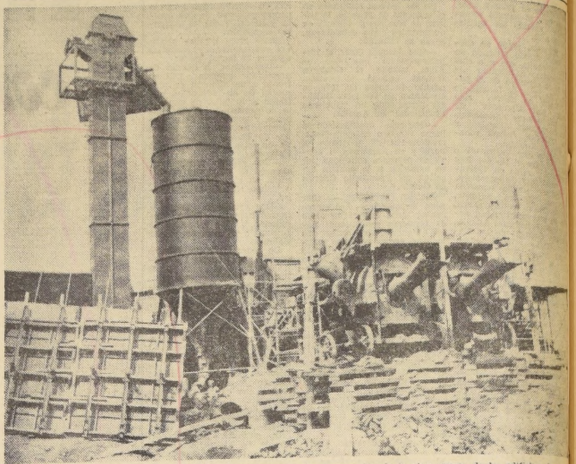
La Planta Deshidratadora de Cemento que aparece en este grabado, aunque parece que nada tiene que ver con el Plan Habitacional, es una pieza vital para la realización del mismo, que funciona también en el mismo sitio de trabajo. Con ella, ahorra tiempo, se aprovecha mejor el material y acelera la ejecución de los trabajos. En base a este sistema, la constructora ha podido adelantar en la construcción de un sector de la citada población, que le permitirá entregar obras antes del plazo fijado por su convenio.
