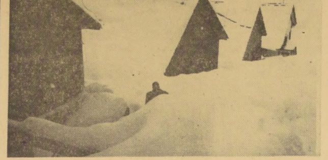
SEWELL. — Soldados del Regimiento Membrillar, de Rancagua, tuvieron que ser enviados al campamento de Sewell para que realizaran labores de limpieza en las calles, que quedaron bloqueadas con más de dos metros
