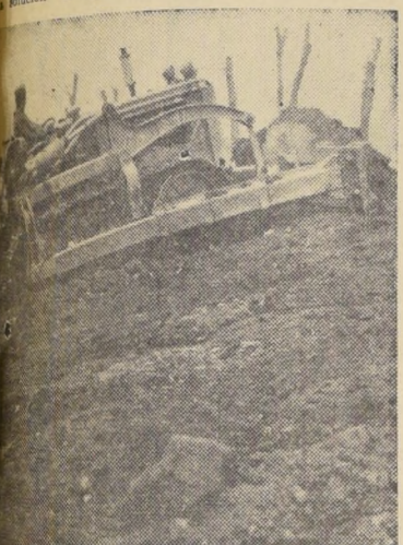
Mediante el uso de tractores a la CORFO y a Talleres Sanitarios del SNS, se está saneando los basurales instalados en terrenos de Peñalolen. En el grabado, un tractor extra una capa de tierra sobre los desperdicios para evitar el foco infeccioso.
