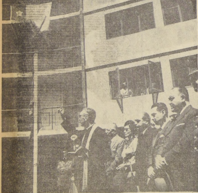
BENDICION DE LA POBLACION.— Corresponde al Reverendo Padre Cirilo Elton bendecir las nuevas viviendas de la Población “Quebrada Márquez” de Valparaíso. En el grabado, el Padre Elton en el momento que asperga el agua bendita sobre las viviendas, durante el acto de inauguración de la población, realizado el viernes 20 del presente al mediodía.
