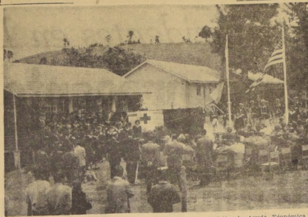
Aspecto de una de las nuevas unidades habitacionales construida cerca de Ancud y recientemente inaugurada, con motivo del viaje de los Ministros del Interior y Salud, al Sur, del Embajador de los Estados Unidos, Charles W. Cole. La unidad fue construida por la Fundación de Viviendas y Asistencia Social y la Misión de Ayuda Económica y Asistencia Técnica de los Estados Unidos (Punto IV), con fondos provenientes de la donación de 20 millones de dólares, suma puesta a disposición de Chile, por el Gobierno norteamericano.
