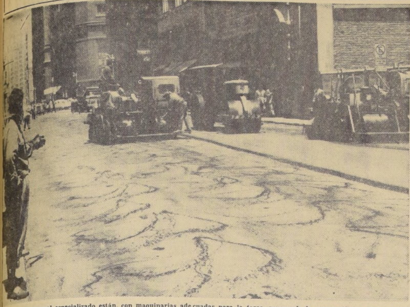
Equipes de personal especializado están, con maquinarias adecuadas para la tarea, repasando la capa asfáltica de las calles principales de la comuna de Santiago, para rectificar su perfil y eliminar los abundantes hoyos existentes. El trabajo se inició en forma intensiva en la calle Morandé, desde Alameda a Mapocho y en los últimos tres días, obreros y maquinarias están ejecutando su tarea en Teatinos. A cargo de los trabajos está la Dirección de Pavimentación de Santiago.
