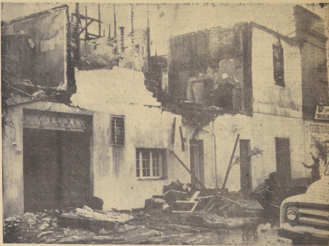
TRES PERSONAS PERECIERON CARBONIZADAS en el segundo piso de la parte del edificio que aparece en la fotografía. Una abuela y sus dos nietos no pudieron escapar, al ser cercados por el fuego en la escalera de acceso.
