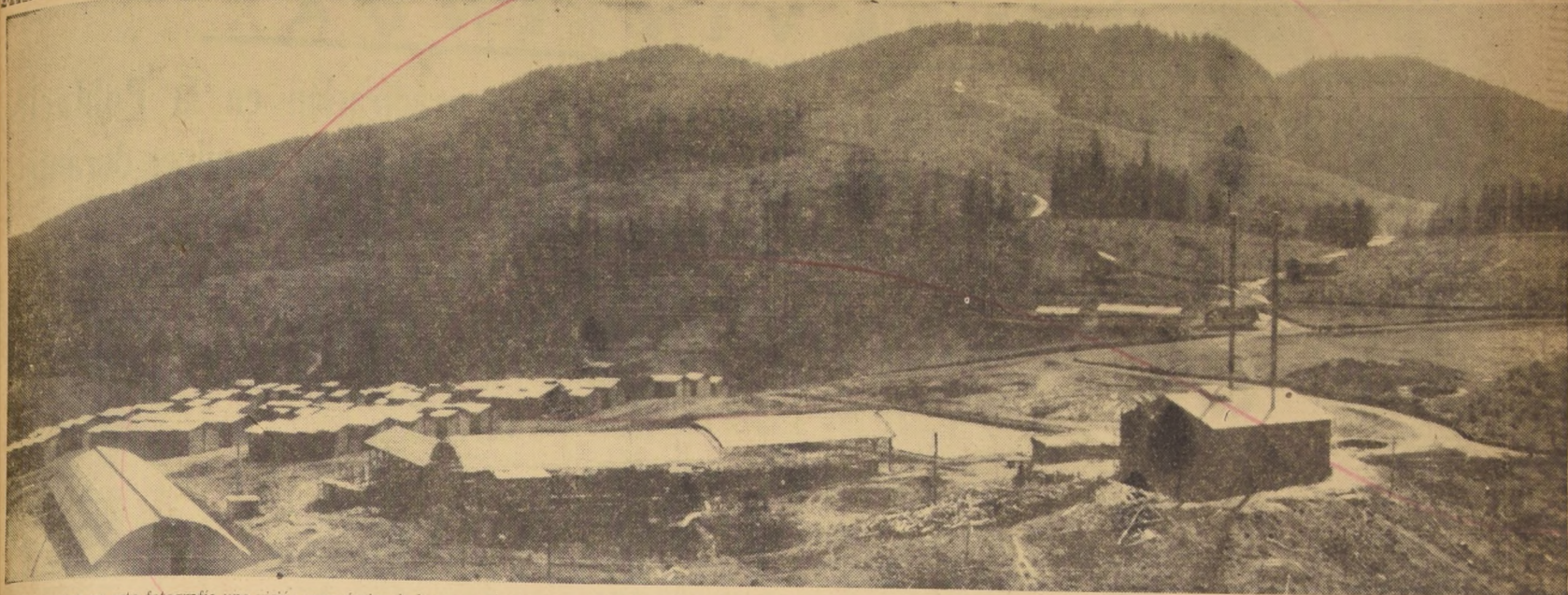
Ofrecemos en esta fotografía una visión panorámica de la nueva planta mecanizada de propiedad de la Firma Maderas Alonso, ubicada en su Fundo Pingüeral, en la provincia de Concepción. Este aserradero, suministrado por la Fábrica "Linck", de Alemania, y que significa una inversión superior a E' 1.000.000, ha sido instalado con las maquinarias más modernas, en la región pinera de mejor desarrollo del país, para alcanzar tres objetivos principales: Aprovechamiento integral de reservas forestales mayores de 30 años, obtención de productos de calidad excepcional con elevados porcentajes destinados a la exportación, y un alto índice de productividad.
