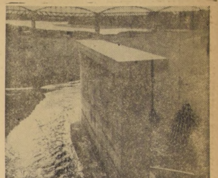
En primer plano aparece, uno de los pilares que sirvió de base para la construcción del puente Suble, a 5 kms. al norte de Chillán, que se inaugura el miércoles. Esta obra estuvo a cargo de la firma Yaconi Hermanos, que empleó en su construcción el sistema hormigón pretensado Freyssinet, prácticamente desconocido en Chile. Al fondo un aspecto del antiguo puente.
