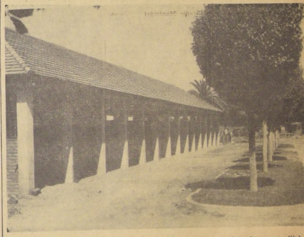
El nuevo paddock del Hipódromo Chile con mayor número y mejores boxes permitirá que los caballos también tengan comodidades. Al final del paddock habrá un redondel y árboles cubrirán el camino central de esta nueva construcción, dándole un hermoso aspecto.
