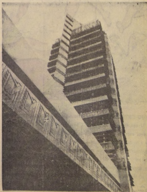
Rascacielos proyectado con grandes secciones en vidrio para permitir el paso intenso de la luz.
