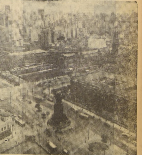
Avenida Tiradentes, estación de ferrocarril del "Jardim de Luz" y un aspecto del centro comercial de Sao Paulo.
