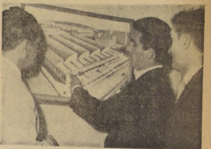
LA FABRICA MORINI: de estas usinas, en Parma, salen, fabricadas una por una, en serie y garantidas, las máquinas "Morini" varias veces campeonas mundiales con Umberto Masetti como conductor de ellas...
