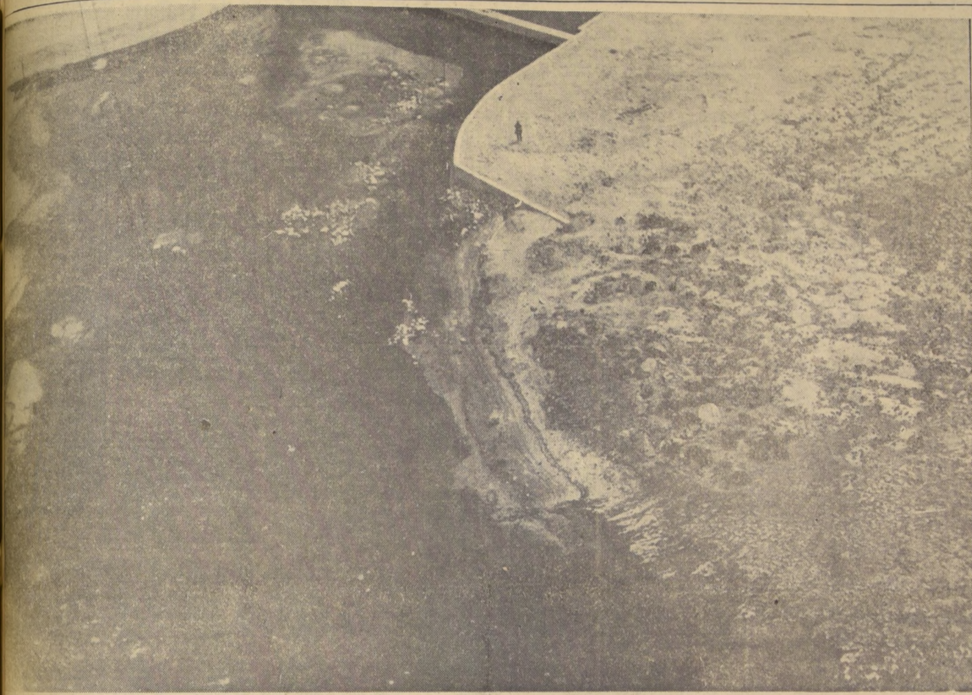
Vista de las aguas del río Lauca al llegar al dique bocatoma, que puede observarse en la parte superior del grabado.
