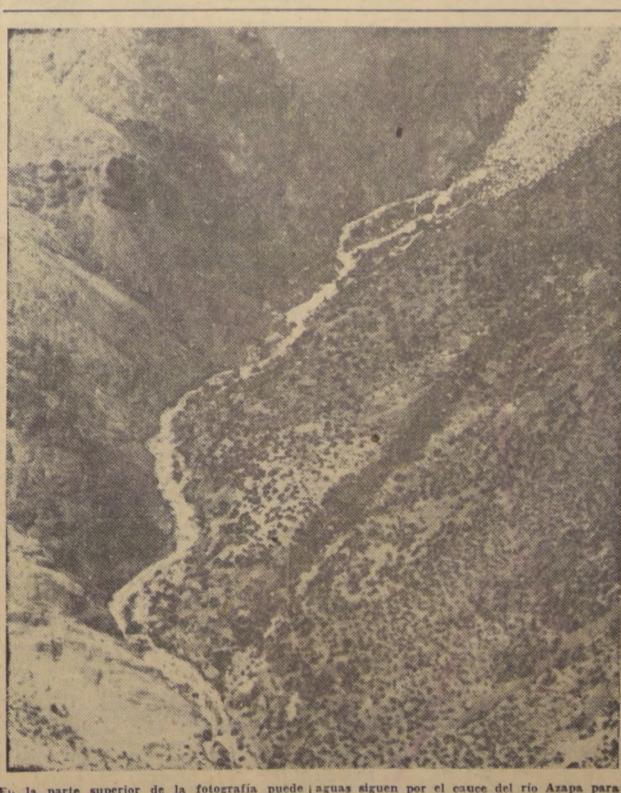
En la parte superior de la fotografía puede observarse la salida de las aguas del túnel que las trae desde la bocatoma de las obras ejecutadas en el río Lauca. A continuación, las
