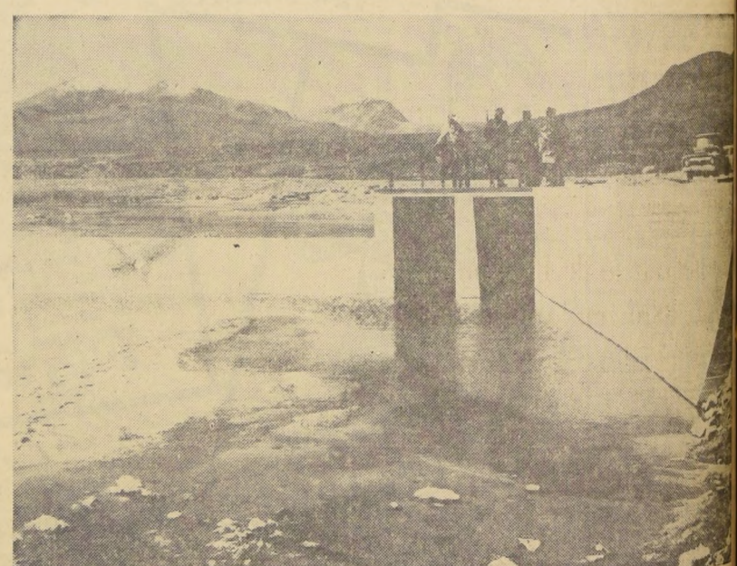
BOCATOMA EN EL RIO LAUCA.— Allí se capta parte del caudal de las aguas que son llevadas a un canal. En la parte superior se ve a los tres carabineros que vigilan el lugar, y a Miguel Sprovera, el conductor que nos llevó al lugar, y que está con una manta sobre los hombros. A la una de la tarde, había varios grados bajo cero.
