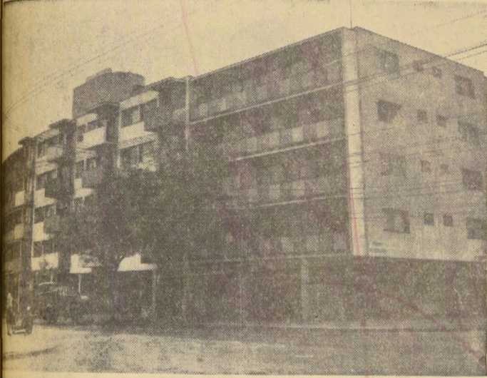
BLOQUE C, con frente a calle San Diego.
