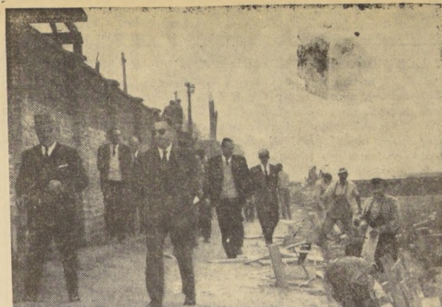
Estas son las obras del paso bajo nivel construido por la Municipalidad de Santiago en la calle Ruble. Los aficionados que viajen desde las provincias, podrán descender del tren en la subestación que habrá en este lugar. En el grabado, el Intendente-Alcalde y jefes de servicios, visitan la obra.
