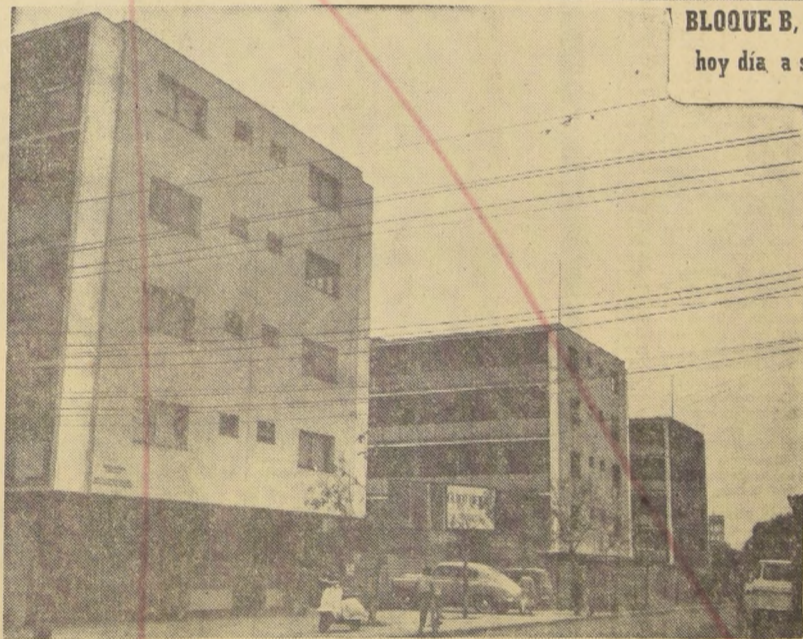
VISTA GENERAL DE LOS TRES CUERPOS DEL GRUPO HABITACIONAL
