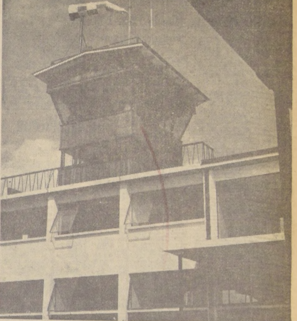
Entre las obras que se han ejecutado en Valdivia para su reconstrucción después de los sismos de mayo de 1960, se encuentra el aeropuerto de Las Marías, el que ha sido ejecutado en tiempo récord y contemplando todos los adelantos modernos para estos recintos. En el grabado se puede apreciar un aspecto de la moderna Torre Central levantada en este aeropuerto para el control del tráfico aéreo. Estas y otras fotografías correspondientes a diversas obras realizadas durante el período de reconstrucción de las
