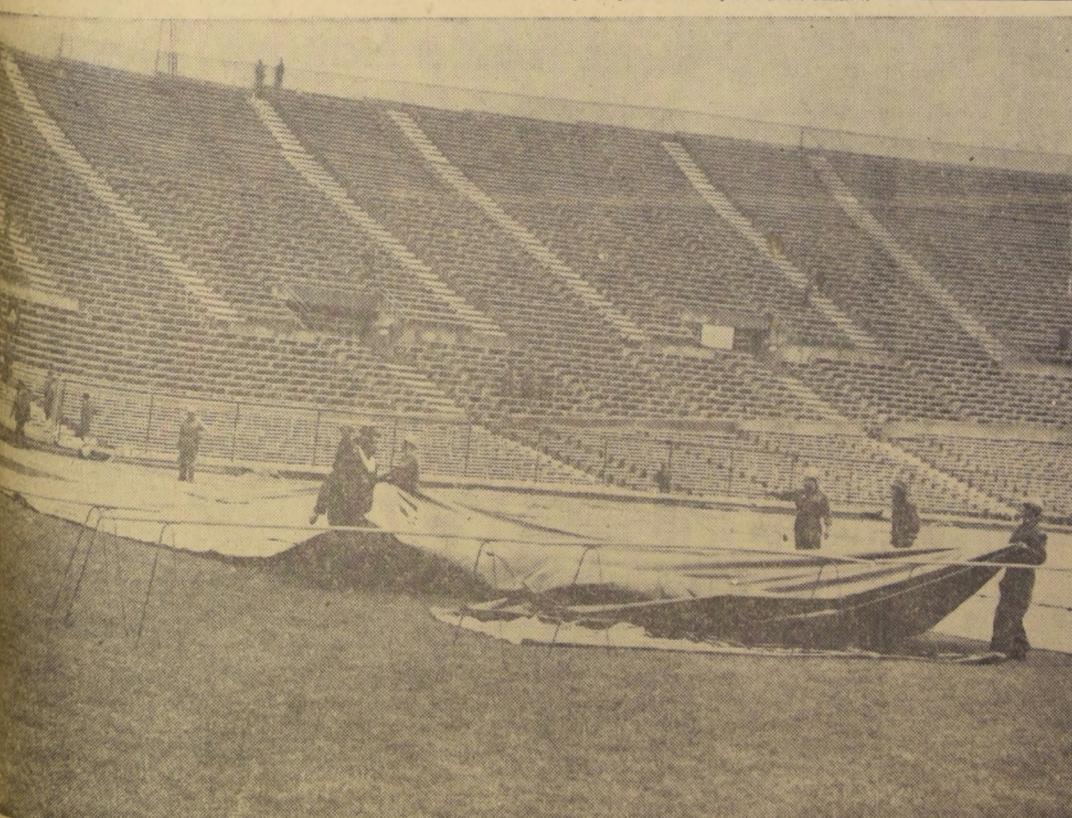
LA LONA PLASTICA fue colocada sobre la cancha, para preservar el campo deportivo del Estadio Nacional para preservarla de la lluvia. Se espera que el primer campo deportivo del país pueda conservarse intacto para los encuentros del Campeonato Mundial. En el grabado, obreros del estadio proceden a ubicar los caballetes y extender la lona.
