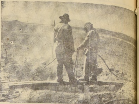
Excavadores en la Pampa Salitrera.
