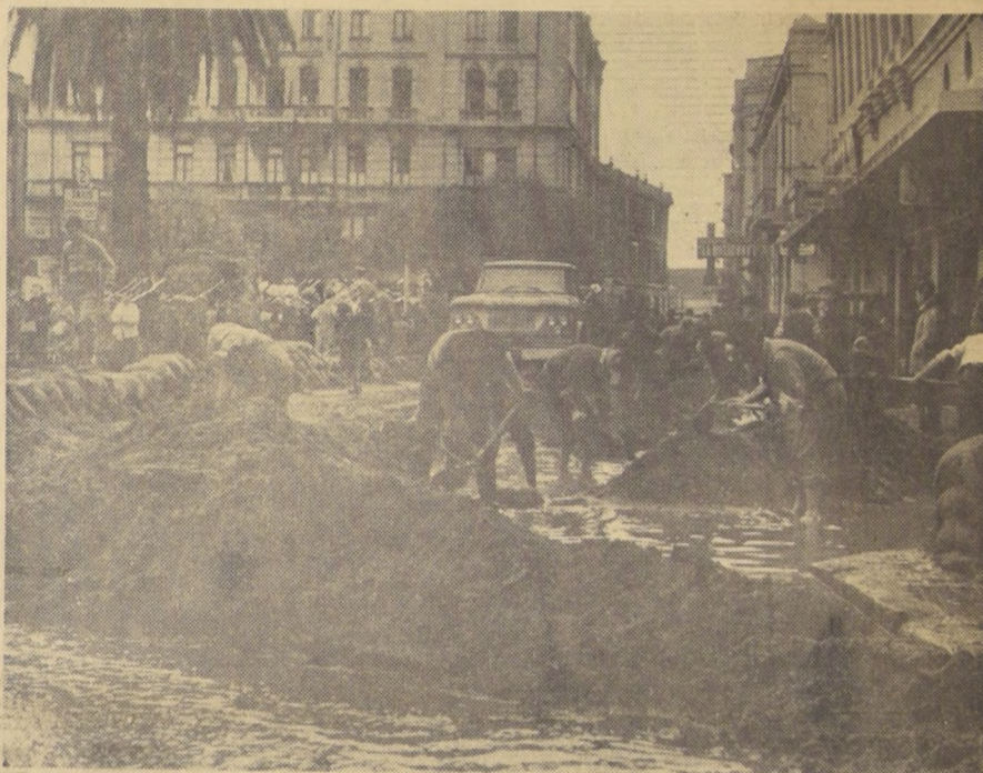
VALPARAISO.- Intransitable quedó el vasto sector que ocupa la Plaza Echaguren, después de los temporales que azotaron a este puerto. Las cuadrillas de obreros han trabajado por turnos las 24 horas del día, para dejar expedito el acceso hasta este populoso barrio. El grabado corresponde a la calle Clave, que está prácticamente inundada. Se observan las cuadrillas de emergencia trabajando arduamente en medio del barro que arrastra todo a su paso.
