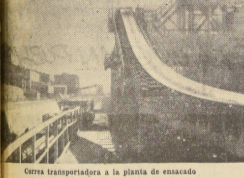
Correa transportadora a la planta de ensacado
