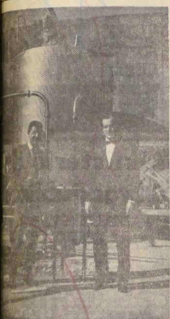
El señor Julio Fontecilla, asesor técnico, y Raúl Isla de Palma, socio y ejecutivo, de la firma Planta Lechera S.A., inspeccionando los nuevos estanques de leche y la maquinaria danesa, que ya está instalada en la Planta.
