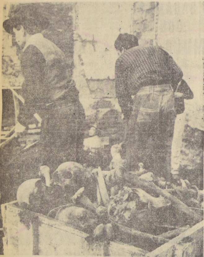
El hallazgo de alrededor de cincuenta osamentas humanas en una demolición que se realizaba en Estado 151, causó sensación a fines de la semana. Las averiguaciones completadas por los pe-
