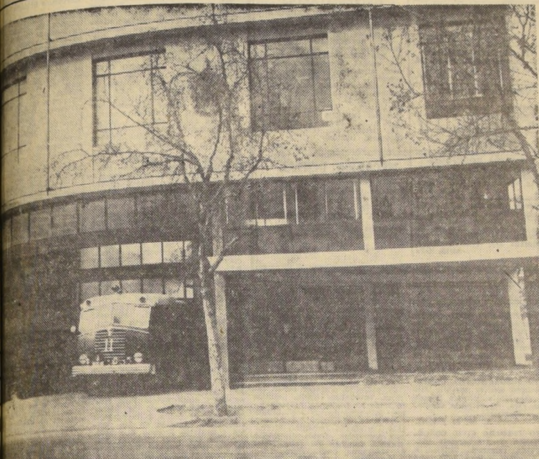
El edificio del nuevo Cuartel para la 11a. Compañía de Bomberos de Santiago "Pompa Italia", que se inaugura esta noche a las 20 horas. La ceremonia contará con la asistencia del Ministro del Interior, Intendente de Santiago, Embajador de Italia, Jefes de Carabineros y del Superintendente don Hernán Figueroa Anguita, quien hará entrega del local a la compañía.
