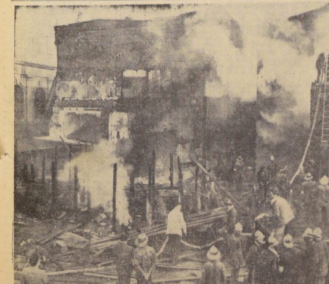
SITIO DE LA TRAGEDIA.— En el grabado, los bomberos retirando el material después de haber sofocado totalmente el siniestro en calle Amunátegui y Huérfanos, que en la madrugada de ayer costó la vida a seis voluntarios y otros 25 que, dieron gravemente heridos. Al fondo puede apreciarse el sector norponiente de la construcción en donde se derrumbó el muro de adobes y ladrillos que sepultó a los seis mártires del Cuerpo de Bomberos de la capital. Diez horas después de la tragedia se retiraron los bomberos, luego que tuvieron la evidencia absoluta de que ningún compañero más yacía bajo los escombros.
