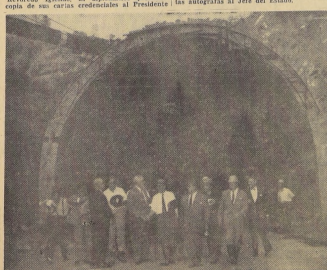
Con asistencia del Ministro de Obras Públicas, Ernesto Pinto Lagarrigue, parlamentarios de la zona y autoridades, ayer en la tarde fueron inauguradas las bocas norte y sur del Túnel de Chacabuco, que acorta la distancia entre la ciudad de Santiago y Los Andes.
