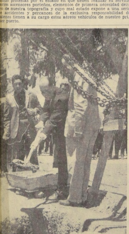
VISA DEL MAR: POBLACION "ALMIRANTE GOMEZ CARRERON". — Un acontecimiento de extraordinaria importancia constituyó la colocación de la primera piedra de la Población "Almirante Gómez Carrerón", de 3.446 viviendas, que construirá la CORVI en Reñaca Alto, para la Armada, a la cual concurrirán autoridades de Viña y Valparaíso. En el grabado, el Alcalde de Viña del Mar, Gustavo Lorea, echa la primera palada de tierra durante el acto, efectuado el sábado pasado. A su lado, el Alcalde subrogante de la Ciudad-Jardín, Pedro Pizarro.
