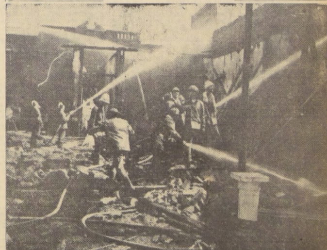
Esta escena fue captada cuando los bomberos terminaban de sofocar el incendio que, a las 6:15 de la mañana de ayer destruyó tres casas, resultando tres heridos, incluyendo dos voluntarios. El fuego comenzó en un taller de carpintería de Alonso Ovalle 860 y se propagó rápidamente a otras dos, cuyos ocupantes perdieron la totalidad de sus enseres, sin haber seguros. Los voluntarios heridos son Guillermo Carrasco Freixa, de 24 años de edad, de la Tercera Compañía; Rafael Cortés Flores, trasladado a la Posta Central, y la estudiante Patricia Graham Méndez, de 17 años, quien sufrió lesiones en el pie derecho.
