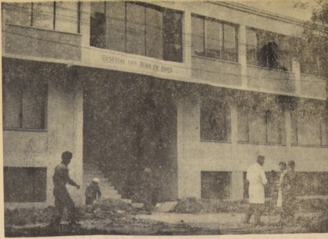
En la esquina de las calles Compañía y Chacabuco se levanta la moderna estructura del edificio que servirá de sede al Centro de Enseñanza de Alimentación, dependiente del Área Hospitalaria Poniente. Su construcción fue posible gracias a una donación de la millonaria norteamericana Helen Lee Lassen y en él se impartirá enseñanza sobre alimentación a las dueñas de casa, alumnas de los Liceos y Escuelas Normales, profesores primarios y enfermos que deben consumir dietas especiales. Sus beneficios se extenderán sobre un área habitada por medio millón de personas. EN EL GRABADO, un aspecto del frontis del nuevo establecimiento, que será inaugurado mañana.
