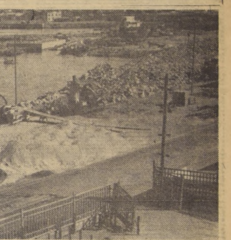
Estas son las obras preliminares del nuevo Molo de Atraque que se está construyendo en Iquique para embarcaciones pesqueras y un nuevo Varadero. En 1965, las exportaciones de productos derivados de la pesca, ascenderán a 45 mil toneladas.
