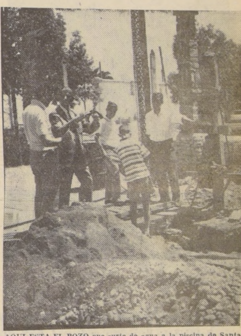
AQUI ESTA EL POZO que surte de agua a la piscina de Santa Laura. Tiene una profundidad de 72 metros y la bomba produce 40 litros de agua por segundo, lo que permite renovar la pileta dos veces a la semana. En el grabado, el dirigente Luis Prieto, da a conocer a LA NACION los pormenores de los trabajos que se realizan.
