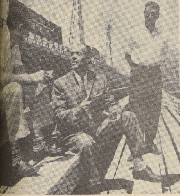
CONSTRUCCIÓN DE LAS NUEVAS GRADERÍAS tiene un costo total de más de ochenta millones de pesos. Quién habla es el administrador de Santa Laura, Luis Prieto Díaz, y a quien se debe en gran parte la construcción de las nuevas tribunas. En el grabado, conversa con LA NACION; más atrás, Juanito Iturrriaga, administrador del Estadio.
