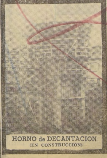
HORNO de DECANTACION (EN CONSTRUCCION)
