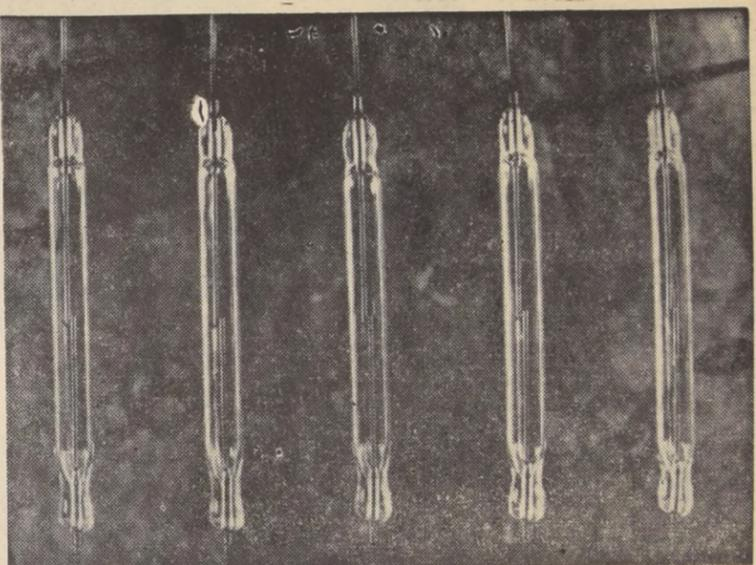
En dos milésimos de segundo estos contactos de gas de protección tramitan un impulso selector. Los tubitos de vidrio están herméticamente cerrados, de modo que el buen contacto no puede ser perturbado con partículas de polvo, influencias atmosféricas, descomposición y elevada humedad del aire.
