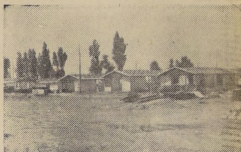
En la comuna de Maipú se levantan las 162 casas construidas por la Cooperativa de Viviendas "José Cardijn", mediante el sistema de ahorros y préstamos. Hoy, a las 11 horas, los futuros propietarios celebran la tradicional ceremonia de los "tijerales", con asistencia de Ministros de Estado y personalidades. En el grabado, un aspecto de la población.
