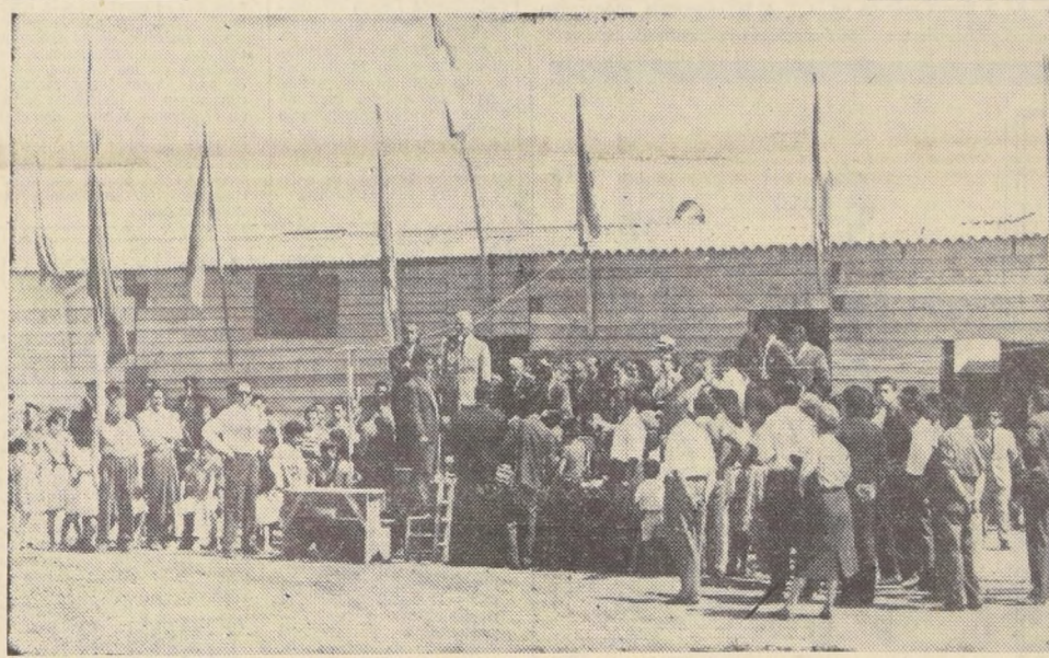
Los pobladores de La Cisterna han dado prueba una vez más de su gran espíritu solidario al construir con su propio esfuerzo una escuela en la Población "José María Caro"...
