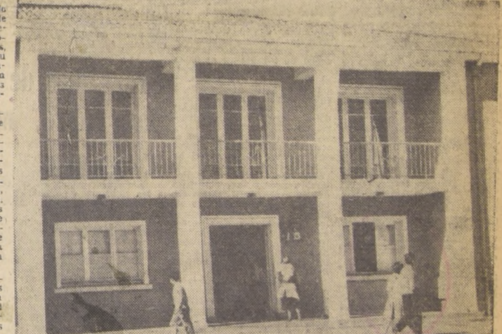
EN EL GRABADO, el frontis del edificio en que funciona la Municipalidad de Lota, ubicada en calle Pedro Aguirre Cerda esquina Arturo Prat, frente a la Plaza. Aquí sesionaban los trapistas
