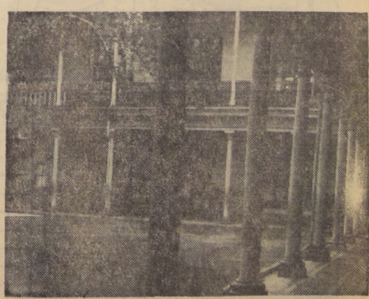
Patio principal del Instituto
