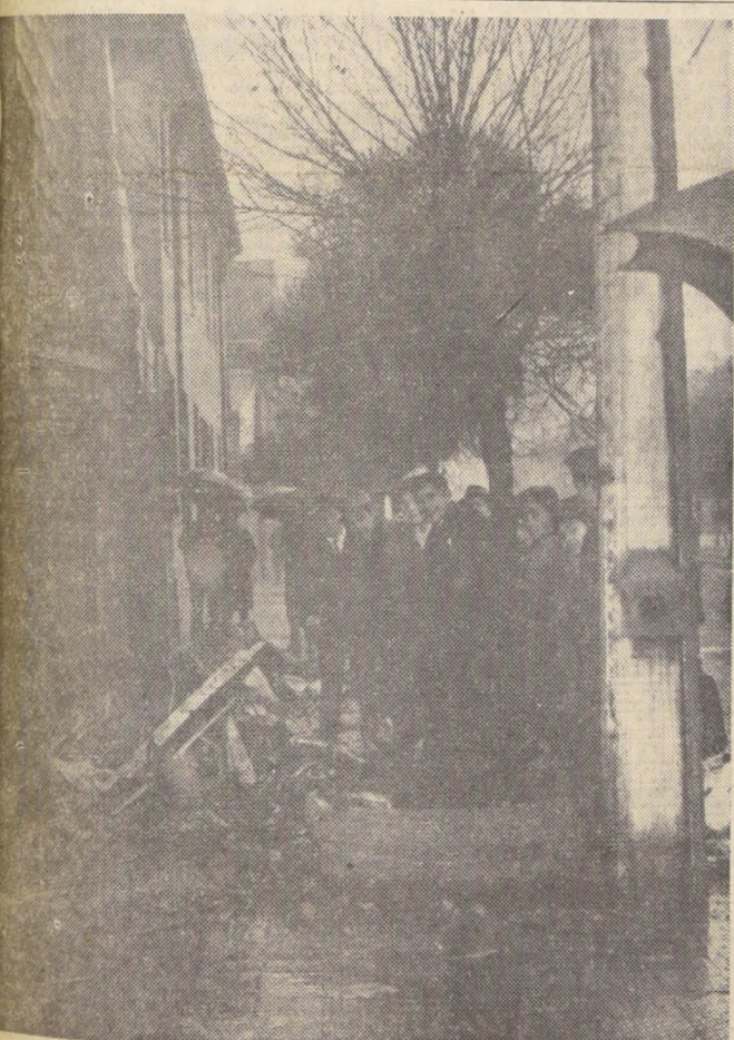
Una muralla posterior y una cornisa que daba a la calle Ramón Carriner se derrumbó en la mañana de ayer en el Liceo No 8 de Hombres, resultando herida de gravedad una estudiante que pasaba en esos momentos frente al inmueble. En el grabado, un grupo de alumnos del plantel observa los efectos de la mañana de ayer en el Liceo No 8 de Hombres, resultando herida de gravedad una estudiante que pasaba en esos momentos frente al inmueble.
