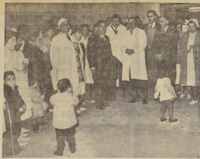
En el mismo Hospital Barros Luco, el Ministro de Salud, luego de visitar las obras de construcción de la sala cuna...
