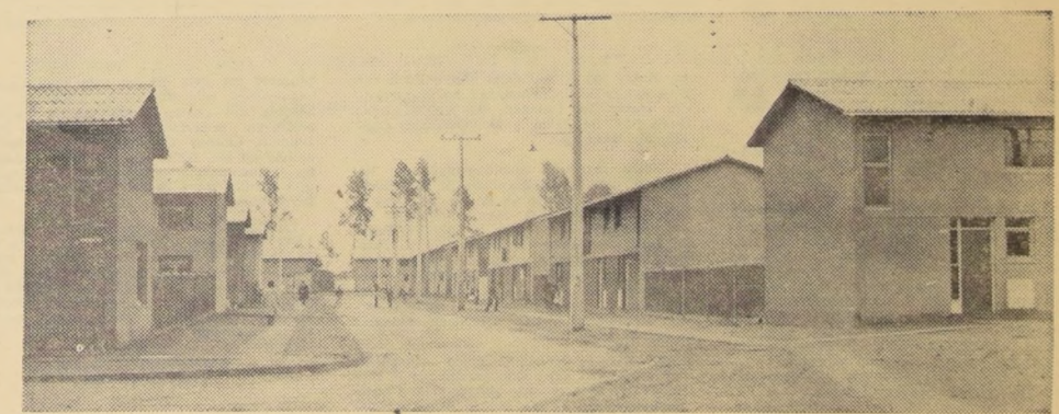
Especial impulso ha dado el Plan Habitacional a través de la CORVI, a la reconstrucción de la Zona Sur, donde once provincias sufrieron, con los sismos de mayo de 1960, la destrucción de miles de viviendas. En el grabado una de las nuevas unidades habitacionales en esa zona.
