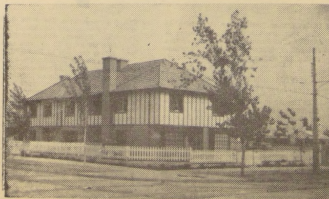
Vivienda construida mediante un Convenio de Ahorro y Préstamo de la CORVI, ubicada en la calle Isabel la Católica 4399, Santiago.
